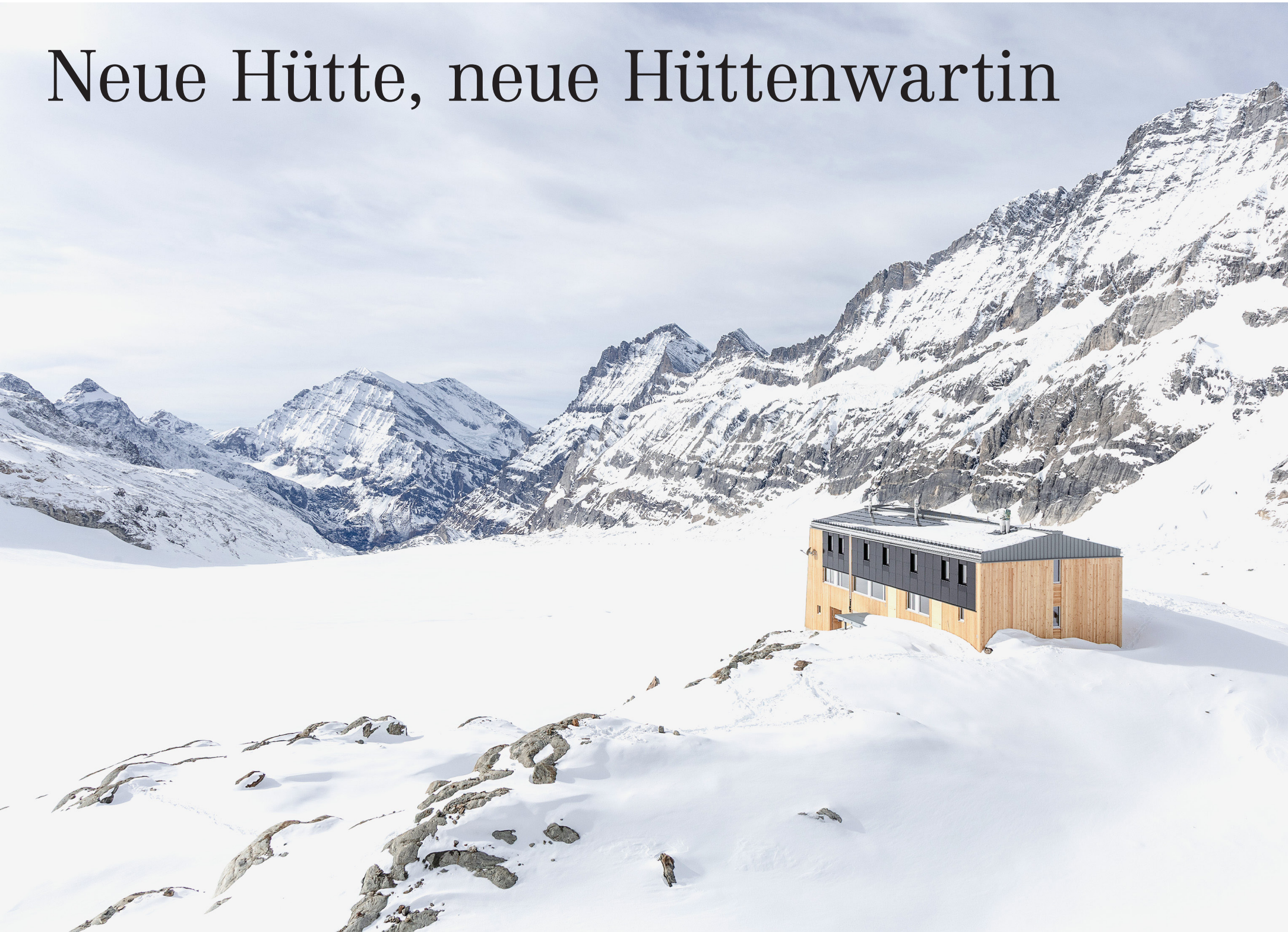
Die neue Mutthornhütte aus Schweizer Lärchenholz entstand 900 Meter westlich des bisherigen Standortes und ist die erste vollständig autarke SAC-Hütte. BILDER: ZVG/ARC1706
